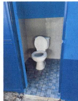
Foto 4: sustitucion de tazas sanitaras
