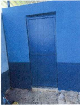
Foto1: sustitucion de puerta de sanitario
