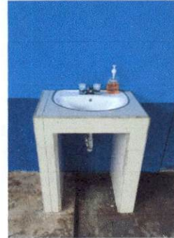
Foto 2: sustitucion de lavamanos
