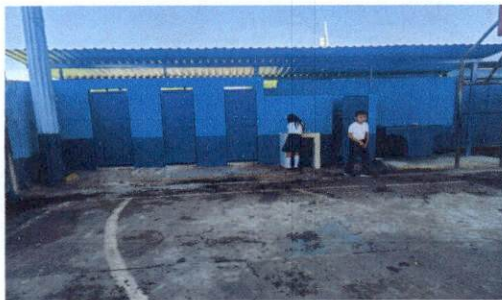
Foto 3: susitución de puertas de sanitario y cambio de techo
